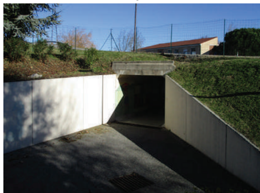
passage piéton sous la voie ferrée
