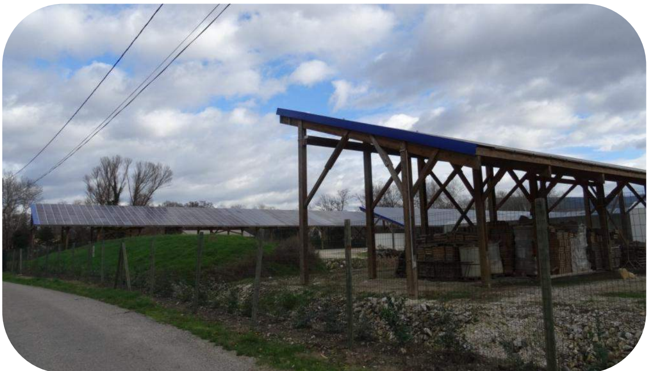
Photographie 32 – Ferme photovoltaïque chemin de La Crema à Cruas (Source : ECO-STRATEGIE, le 12 janvier 2016)
