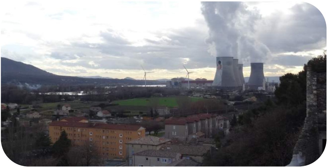
Photographie 33 – Parc éolien de Cruas (Source : ECO-STRATEGIE, le 12 janvier 2016)
