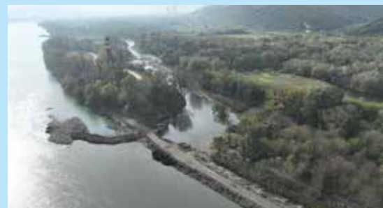
Réhabilitation écologique sur 1,4 km de la lône du Gouvernement : nouveau lieu de balades.
